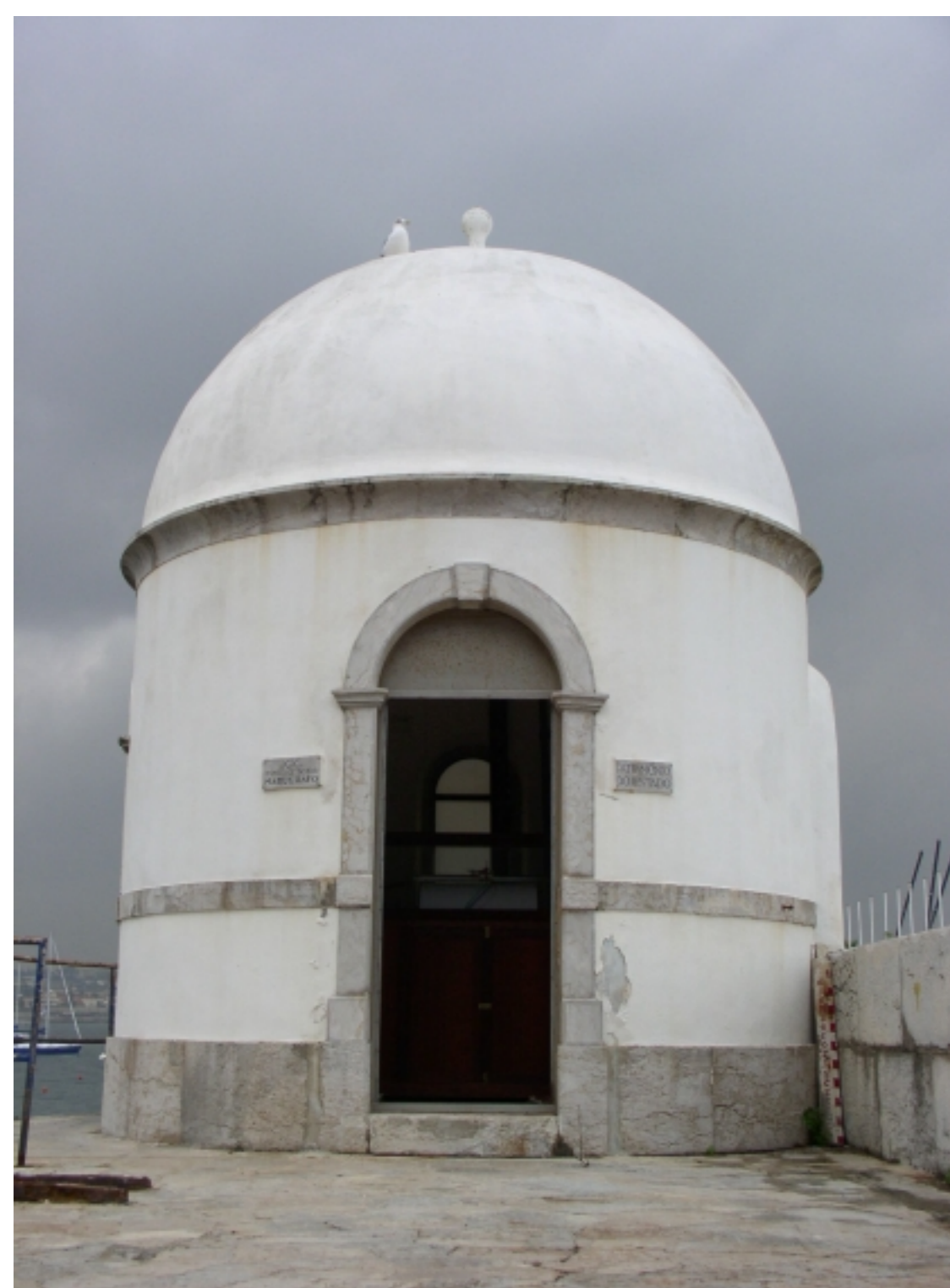
Casa Abrigo do Marégrafo Analógico
