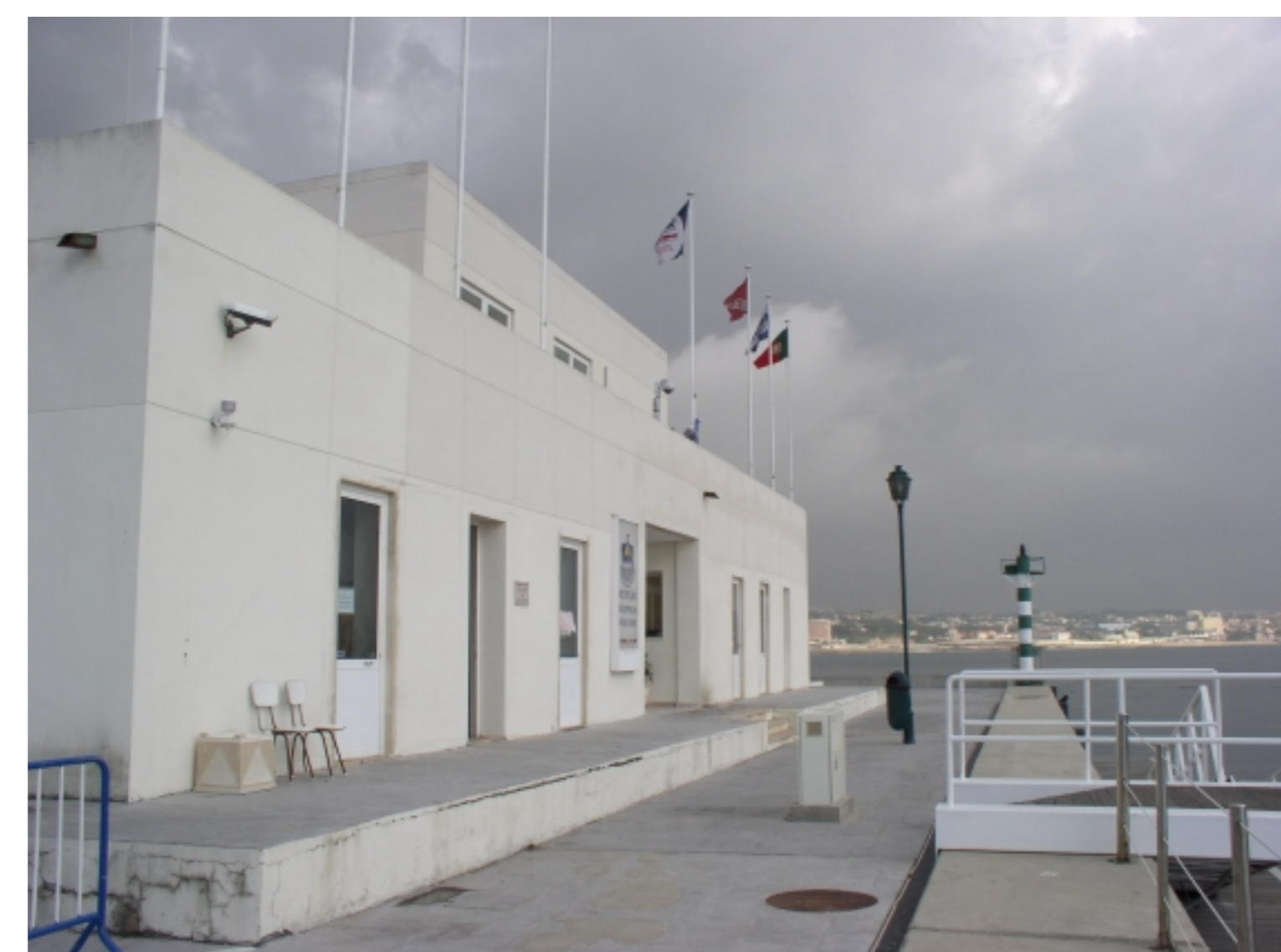
Casa Abrigo do Marégrafo Acústico - Marina de Cascais
