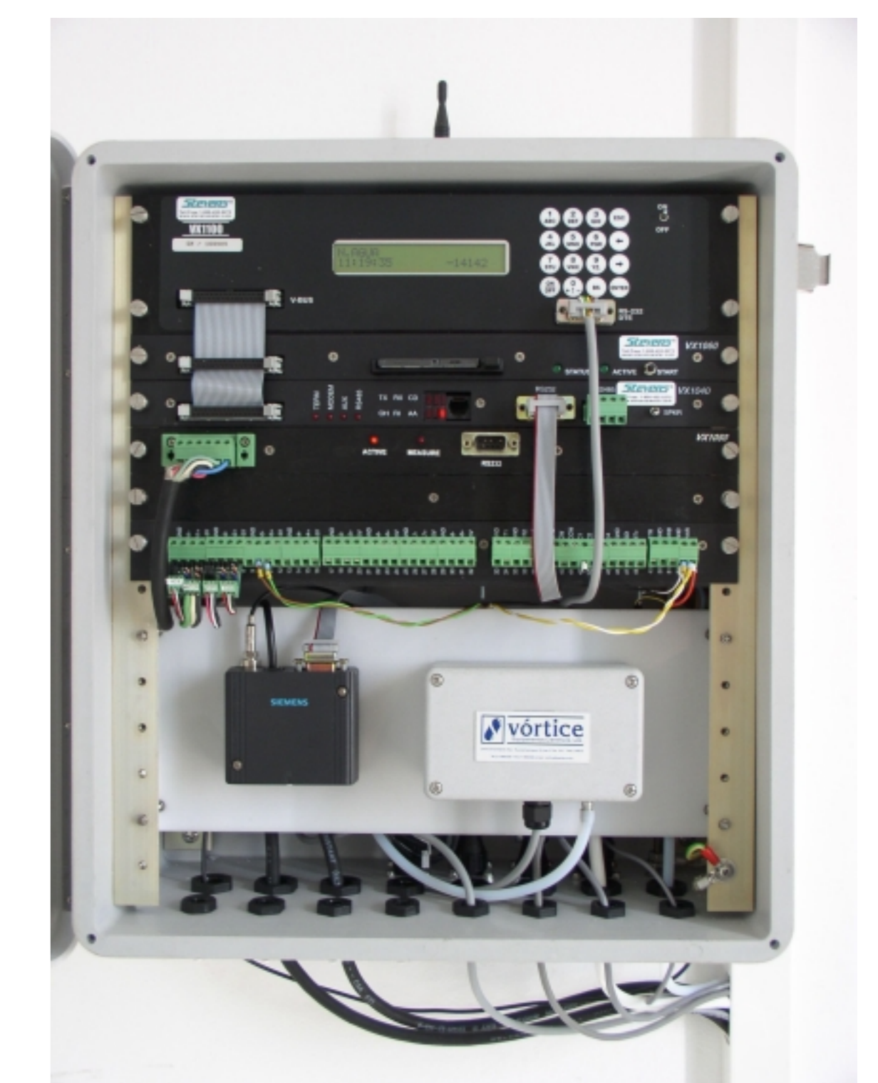
Consola de registo e transferência dos dados maregráficos
