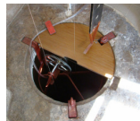
Pormenor do poço
