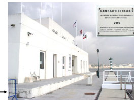
Casa Abrigo do Marégrafo Acústico
