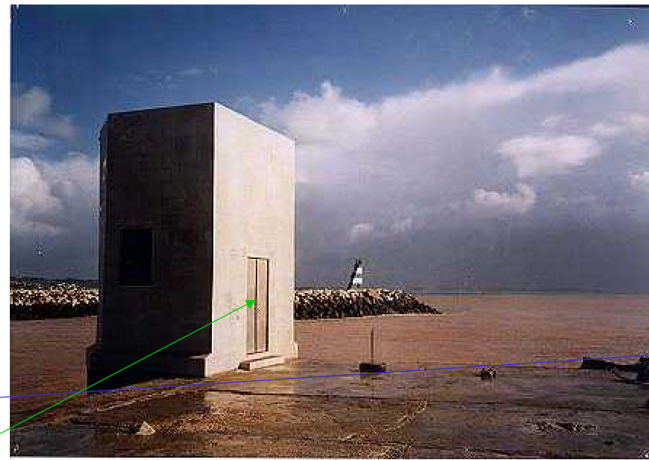
Marégrafo de Lagos
