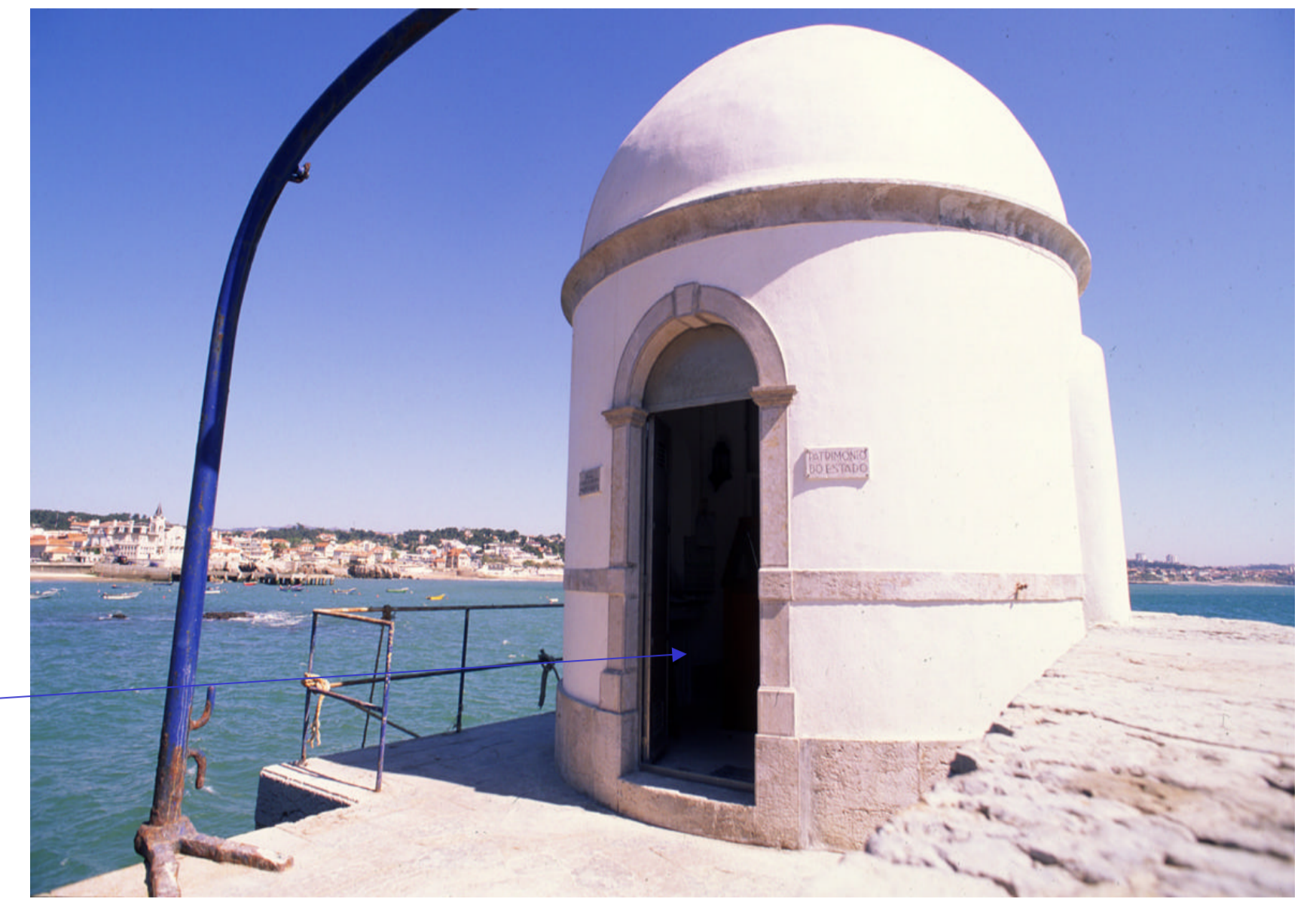
Marégrafo de Cascais
